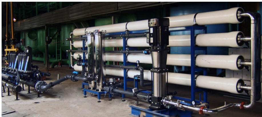
**Описание импортозамещающей продукции:** мембранные установки для ультра- и нано-фильтрации являются ключевым элементом новой безреагентной технологии очистки поверхностных вод от органических соединений различного происхождения и минеральных солей (преимущественно солей жесткости).
